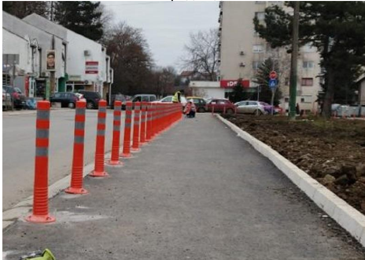
Слика 15. Пример на поставување на еластични столбчиња
